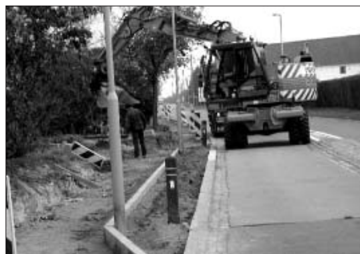
Nouvelle liaison piétonne avec Louvain-la-Neuve, rue des Trois Burettes.
